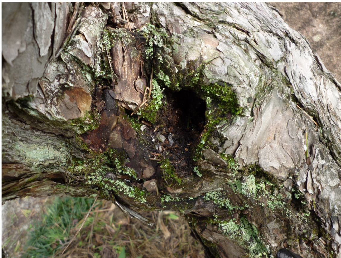
【写真2】腐食による傷の一部
